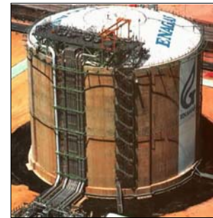
LNG Storage Tank
