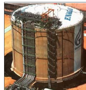
LNG Storage Tank
